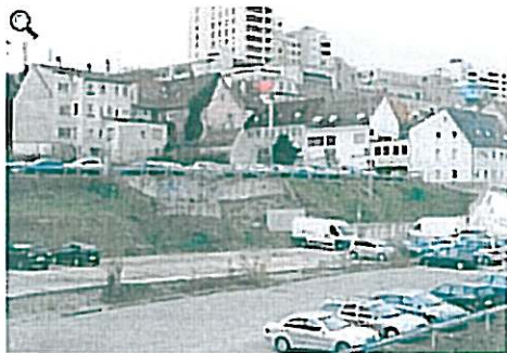
Parkplatz, Brachland und Ruinen: So sieht das Walcker-Areal gegenüber vom Schloss derzeit noch aus.
