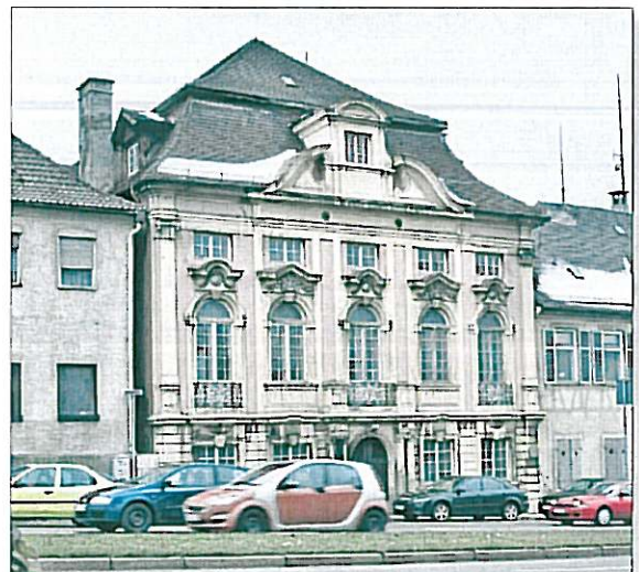
Das historische Gebäudeensemble an der B 27 soll nach dem Willen der Stadtverwaltung in Zukunft als Hotel genutzt werden. Grafenbau (im Bild) und der neben ihm liegende Gesandtenbau stehen unter Denkmalschutz. Der Schlosshof an der Ecke zum Kaffeeberg darf abgerissen werden. Die Stadt sucht einen Investor, der die heruntergekommenen Gebäude saniert und zum Hotel ausbaut. Bild: Dressel
