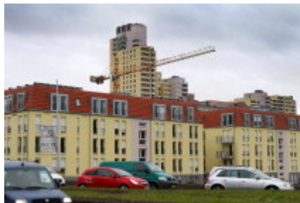
Die neuen Gebäude auf dem Walckerareal in Ludwigsburg. Dahinter das Marstallcenter. Foto: Martin Kalb
